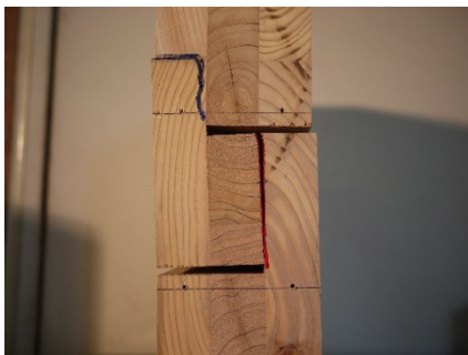
接着面に沿って亀裂(CH2 側)
