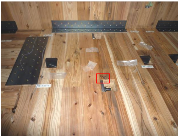
写真 9.6-7 3階 南構面 室内側 ・壁-まぐさ引きボルトの壁側で CLTの割れ
