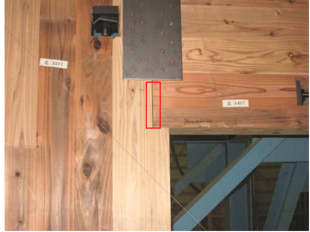
写真 9.7-6 2階 北構面 室内側 ・ 壁-まぐさ間の開き
