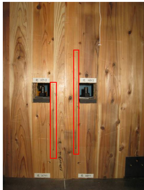
写真 9.5-4 1階 北構面 室内側 ・CLT挽き板の横はぎ部の開き
