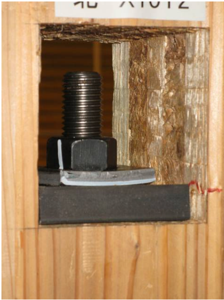
写真 9.7-5 1階 北構面 室内側 ・ 1階の壁脚引きボルトの座金の変形
