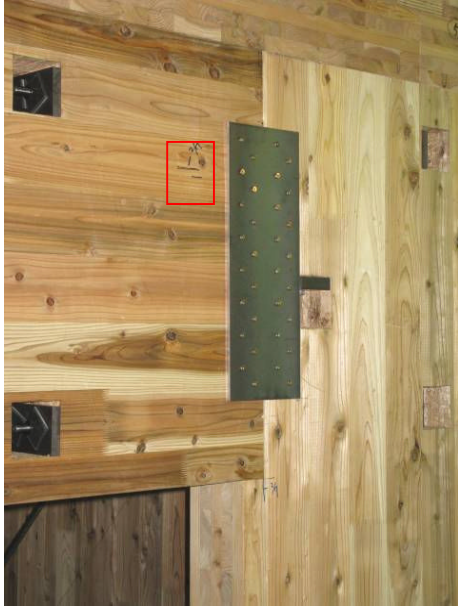
写真 9.6-8 1階 北構面 室外側 ・壁一まぐさ引きボルトのまぐさ側で CLTの割れ
