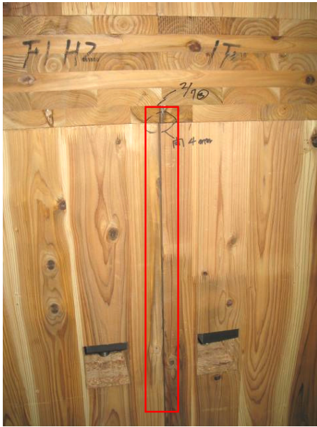
写真 9.8-7 1階 北構面 室外側 ・壁一壁間に開き
