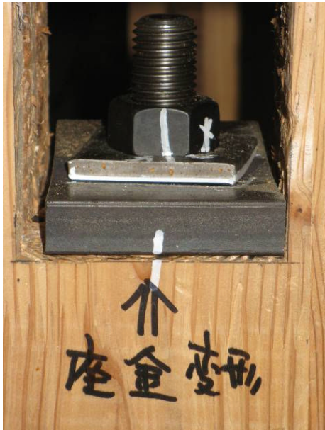
写真 9.8-1 1階 南構面 室外側 ・壁脚引きボルトの座金の変形
