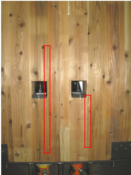
写真 9.5-1 1階 南構面 室外側 ・CLT挽き板の横はぎ部の開き
