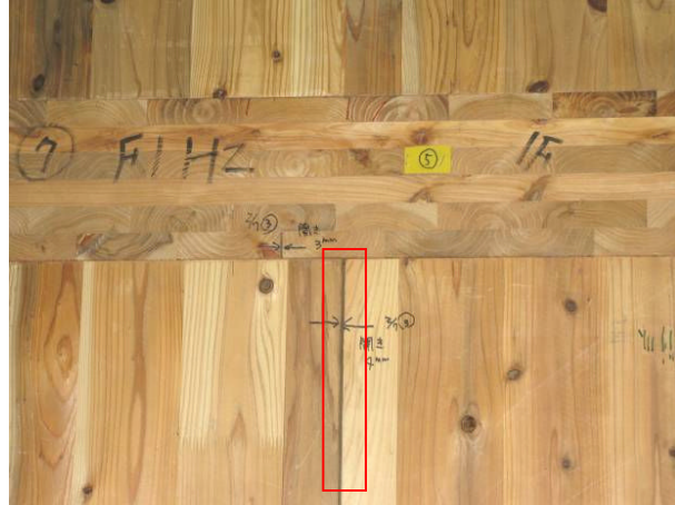
写真 9.8-2 1階 南構面 室外側 ・壁-壁間の開き
