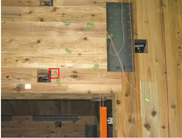
写真 9.6-1 1階 南構面 室外側 ・壁-まぐさ引きボルトのまぐさ側で CLTの割れ
