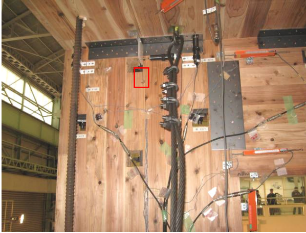
写真 9.6-5 2階 南構面 室内側 ・壁-まぐさ引きボルトの壁側で CLTの割れ
