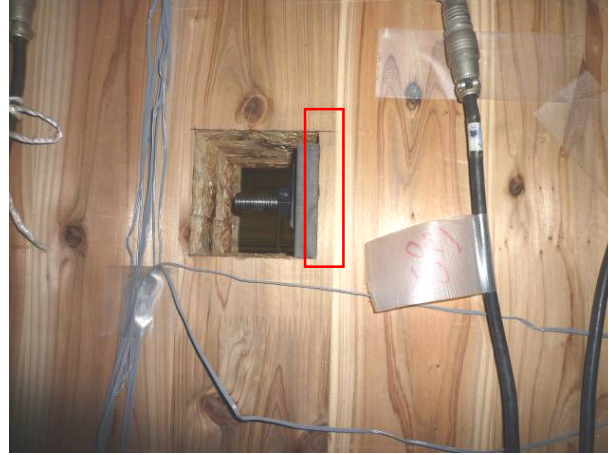
写真 9.6-13 3階 北構面 室内側 ・壁—まぐさ引きボルトの壁側で 座金のCLTへのめり込み
