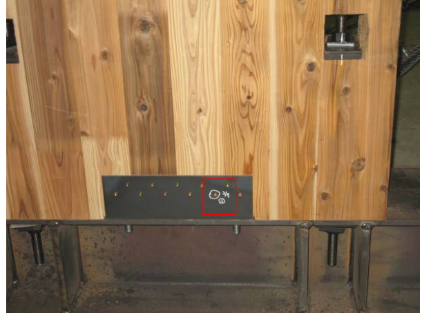
写真 9.6-9 1階 北構面 室外側 ・せん断抵抗金物の木ねじの頭の傾き
