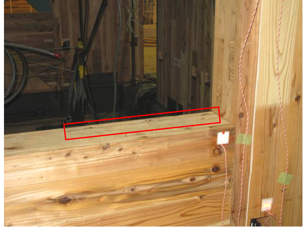
写真 9.6-2 1階 南構面 室外側 ・腰壁側面でCLTの割れ
