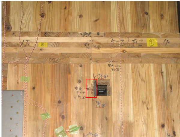
写真 9.8-3 1階 南構面 室外側 ・壁-まぐさ引きボルトの壁側で座金のCLTへのめり込み
