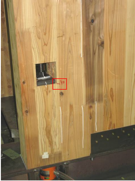
写真 9.7-1 1階 南構面 室外側 ・壁一まぐさ引きボルトの壁側で CLTの割れ
