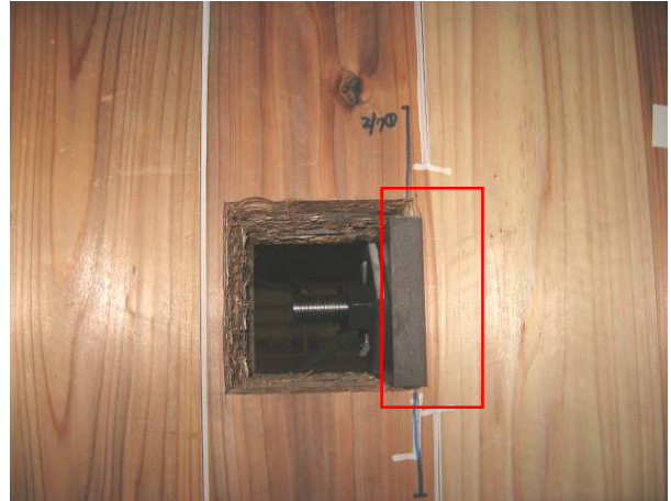
写真 9.8-8 2階 北構面 室内側 ・壁一まぐさ引きボルトの壁側で 座金のCLTへのめり込み
