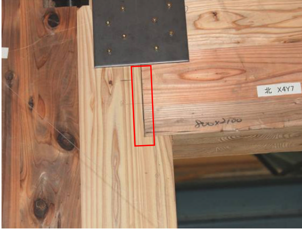
写真 9.6-12 2階 北構面 室内側 ・壁—まぐさ間の開き
