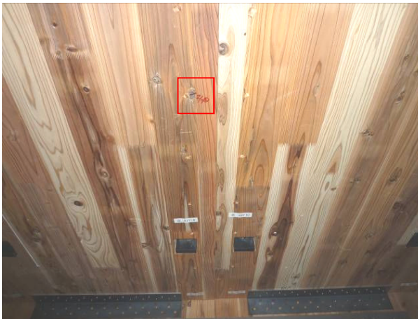
写真 9.7-7 3階 北構面 室内側 ・ 壁-壁間を接合する木ねじの周りでC L Tの割れ
