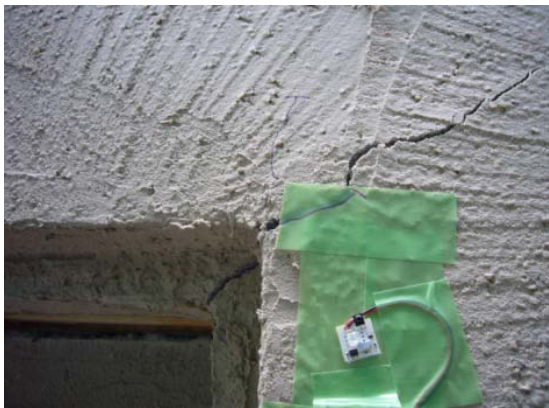
写真 9. 2. 4. 4 モルタル外壁開口隅ひび割れ
