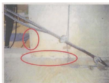
⑥釘周り 石膏ボード圧壊
