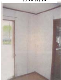
⑤内装仕上げ材の切れ
