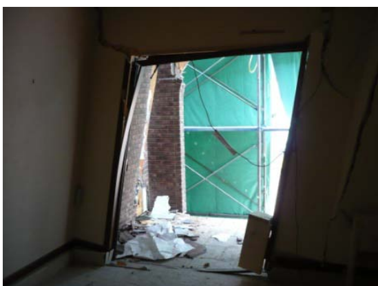
写真 9. 2. 4. 6 玄関の枠材の外れ ( 1/15.\text{rad.} )
