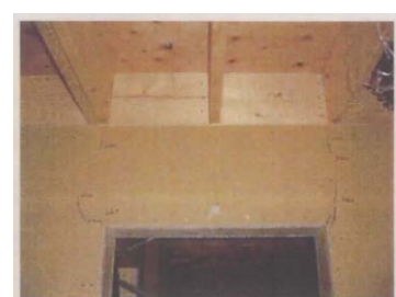
⑥開口部周りの 石膏ボード割れ
