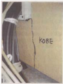
①外装仕上げ材の割れ
