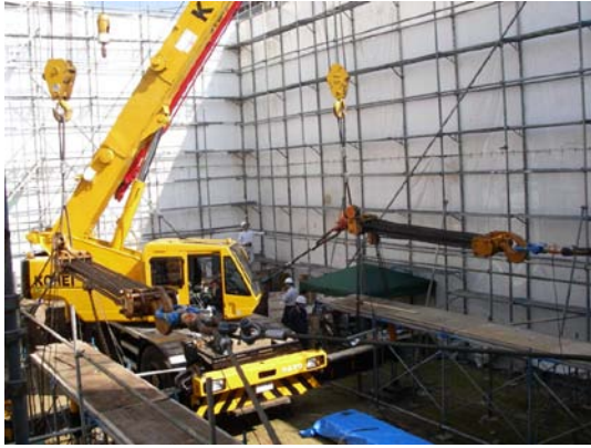
写真 9. 2. 4. 2 チェーンブロックの設置状況
