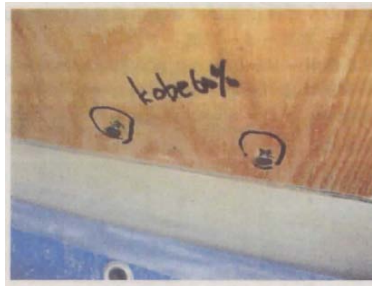
③合板釘抜け
