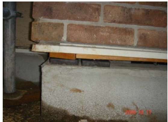
写真 9. 2. 4. 5 外壁線の土台の浮き上がり
