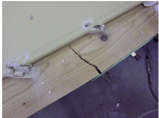
柱の曲げ破壊 (3.8×32mm 一方向)
