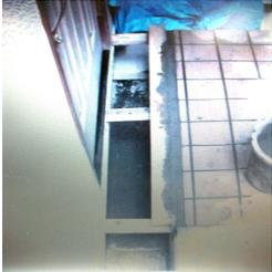
ポーチ土間に設定した遮断溝の施工事例（遮断溝の底面の水上レベルは基礎天より下げる。）
