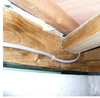
外壁下断熱材押え不備による湿気抜け
