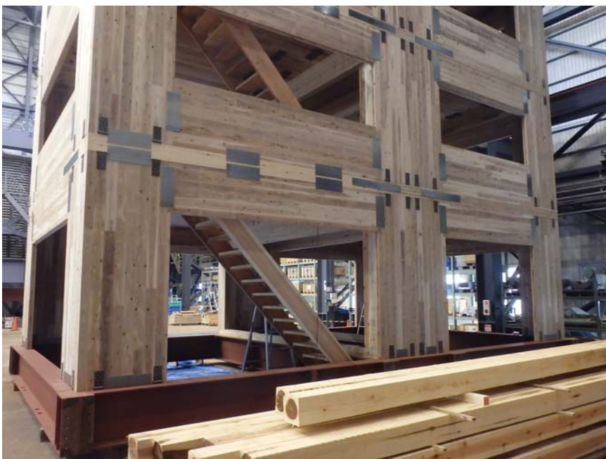
(参考) E 棟 X0 通り方向より (試験体内部に壁は無く、開口幅は 4m)
