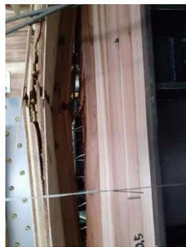
構造用集成材の亀裂
