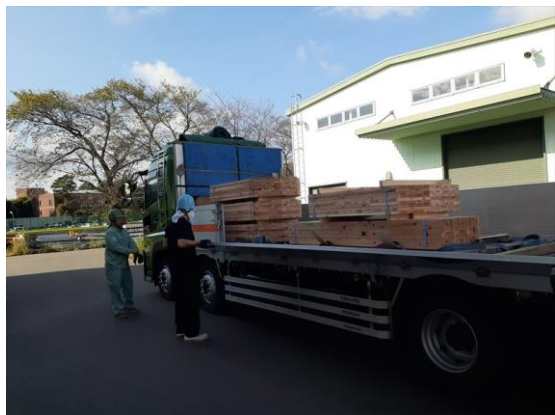
CLT パネル等搬入状況
