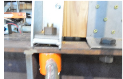
C 左側脚部浮上がり (試験後)
