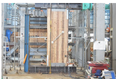
B 試験体全体図 (試了後)
