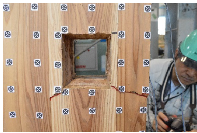
D ボルト穴・表(試験後)
