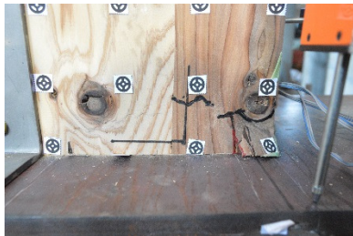
D 圧縮側脚部・表(試験後)
