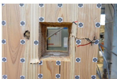
D ボルト穴・表(試験後)
