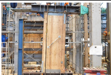
B 試験体全体図 (試験後)
