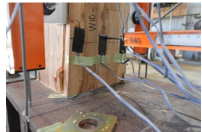
I 圧縮側脚部・(試験後)
