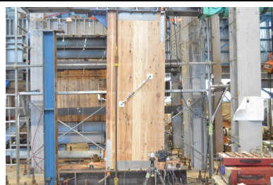
B 試験体全体図 (試験後)
