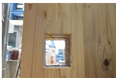
D ボルト穴・裏(試験前)
