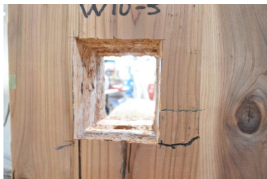
H ボルト穴・裏(試験後)
