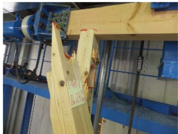
写真 14. 4-4 1-90C-1 圧縮筋かきの座屈に伴う引張筋かい端部の割れ
