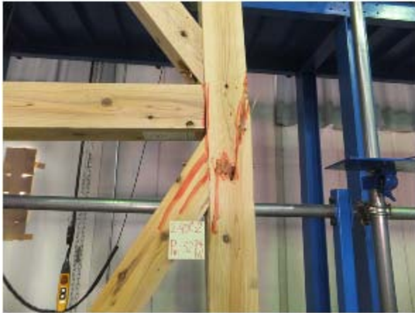
写真 14. 4-13 2-90C-2 柱の曲げ破壊
