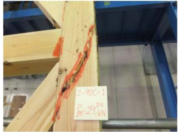
写真 14. 4-10 2-90C-1 柱の曲げ破壊
