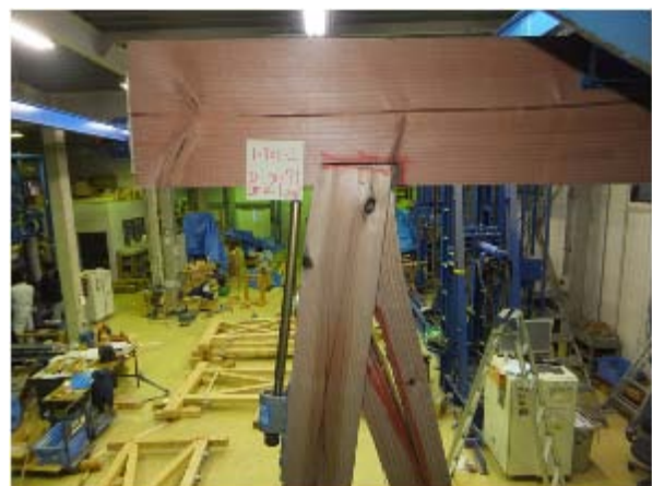
写真 14. 4-6 1-90C-2 圧縮筋かい端部の割れ
