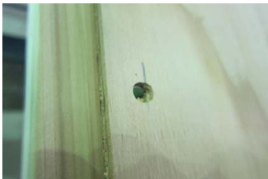
写真 2.4.3 面材へのくぎ頭のめり込み
