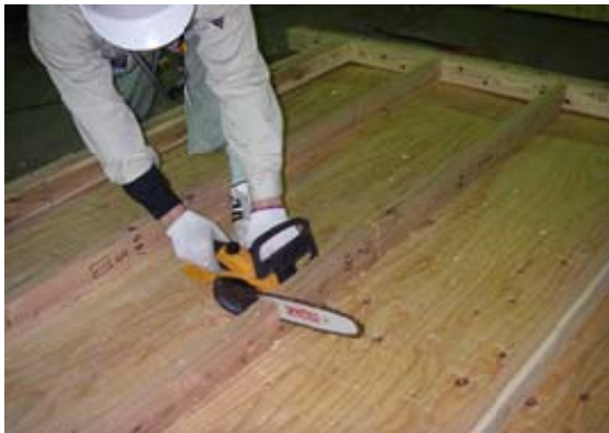
写真 2.5.1 耐力壁から試験片採取状況
