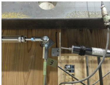
A 入隅部から亀裂 (1/50rad 引) ※200kNの低下※すべりの影響?
