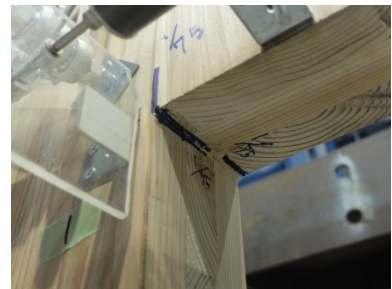
B 入隅部から亀裂 (1/75rad 引)
