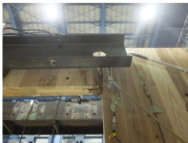
D 入隅部から破断 (試験終了時)
