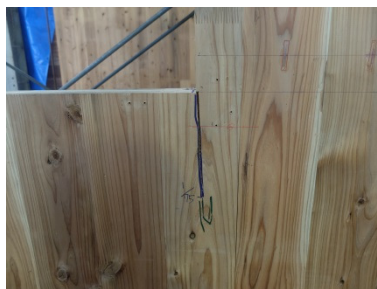
G 入隅部から亀裂 (試験終了時)
