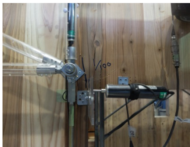
A 入隅部から亀裂 (1/100rad 引)
