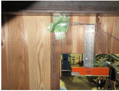
開口部右上(裏側)亀裂(-1/100 押)
