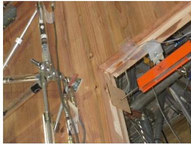
開口部(左上)亀裂(1/50 引)
