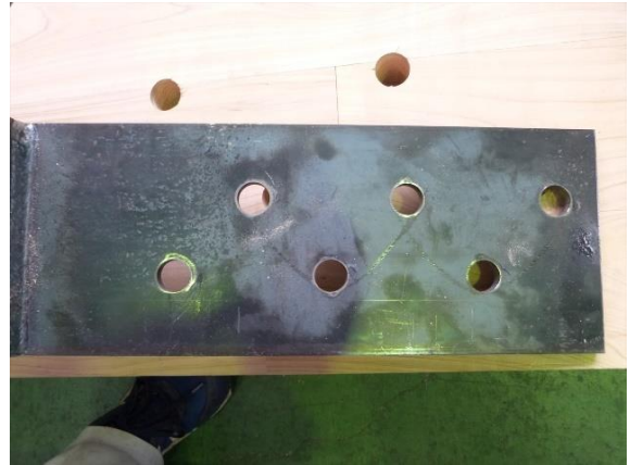
鋼板孔部 状況
