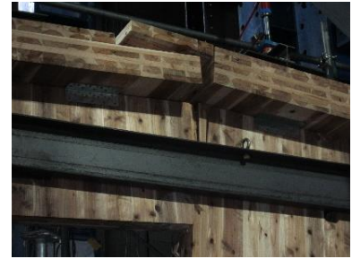
(6) *注①床パネル破壊(引き切り)
