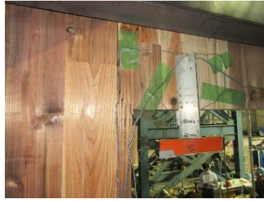
(2) 開口部右上裏側亀裂(-1/50 押)
