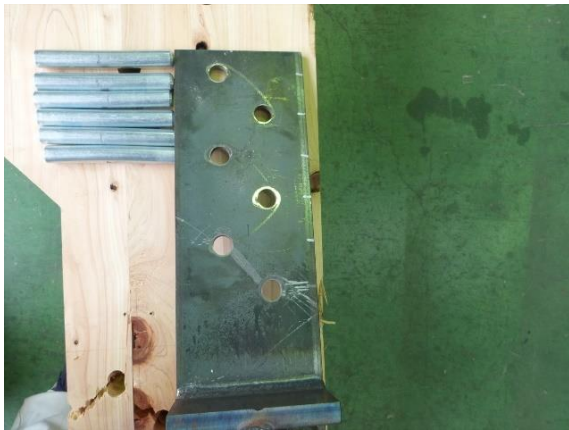
鋼板孔部 支圧変形
