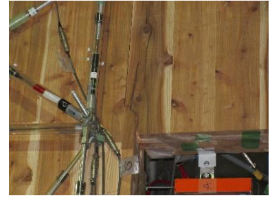
(3) 開口部左上亀裂(1/50 引)
